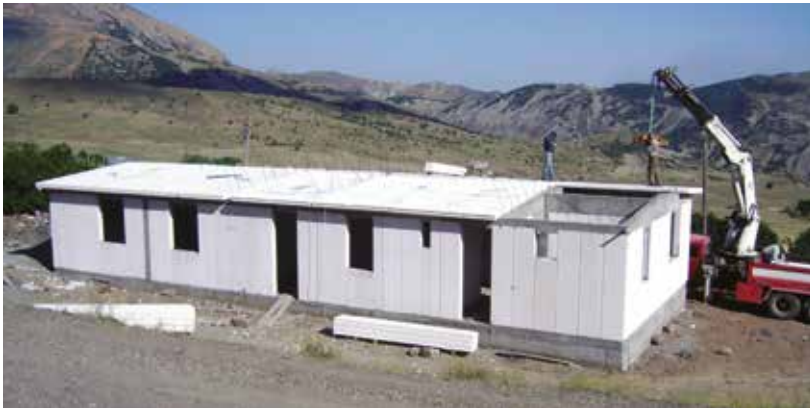
Taşıyıcı Düşey Duvar Elemanları
