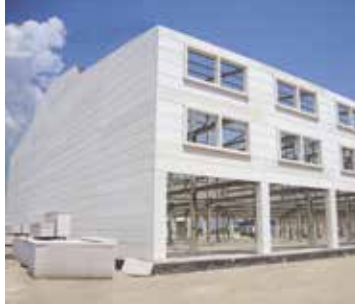
Yatay Duvar Elemanları
